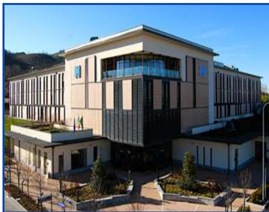
Figura 3: Ospedale Unificato di Broni-Stradella
